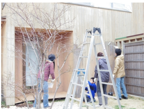
この日は寒い中、作業をして頂きました。
