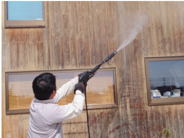
まずは高圧洗浄機で汚れを落とします。
