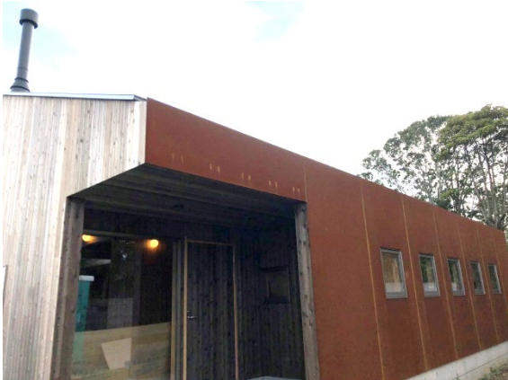
板張りの外壁は全てお施主さんが塗装しました 錆びたコルテン鋼がとてもいい表情です
