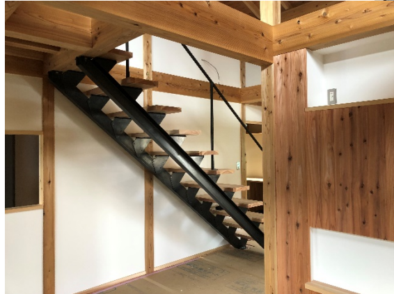
ビルなどの構造にも使う本物の鉄骨です 杉板と鉄の組み合わせがとても素敵です!
